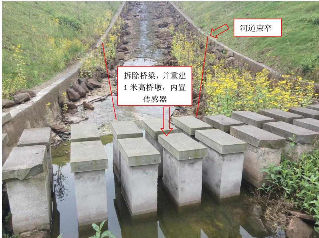
备注：将图片中的桥梁拆除，并在原位置沟道中央修建高 1m 的桥墩，两侧沟道边墙也加高至 1m。
